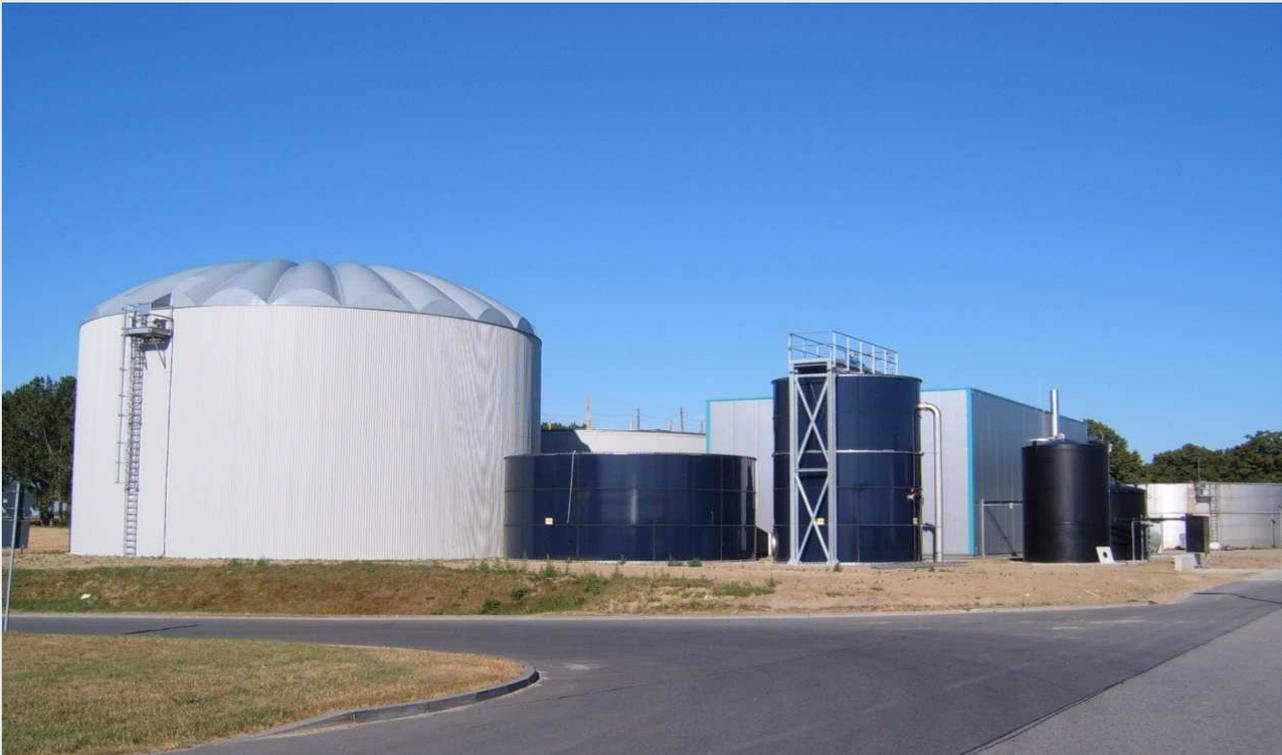
Im Rahmen eines Pauschalauftrages erfolgte 2006 die Erweiterung einer bestehenden aeroben Abwasserbehandlungsanlage in der milchverarbeitenden Industrie um eine anaerobe Vorbehandlung, eine MAP-Fällung sowie eine Biogasverwertung mit Blockheizkraftwerk.
